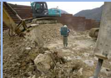
引き起こし作業完了 破碎後 砕石化工法もあります
