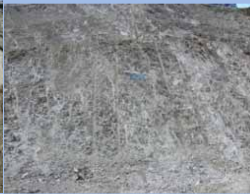
法面整形セパレート工法による法面整形工 19
