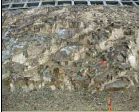
従来の法面整形工法(ブレイカ仕上げ)
