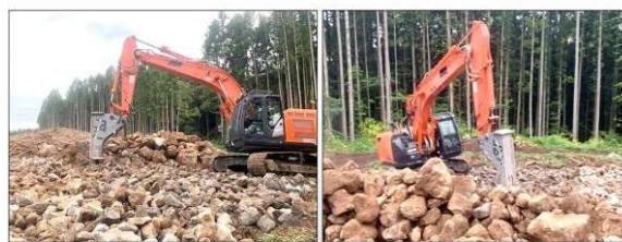
吹浦地区道路改良工事
